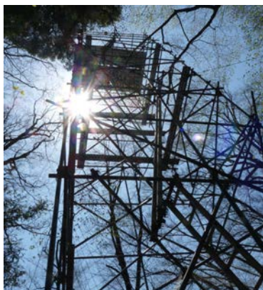
図1. 秩父の林内に設置された鉄塔。この最上部にライブマイクが設置されている。
